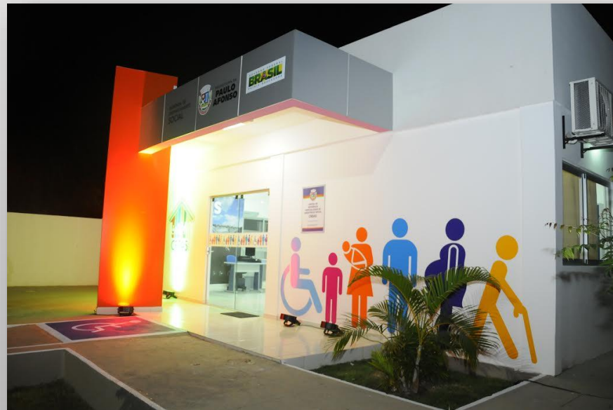
Figura – Instalações do CREAS
